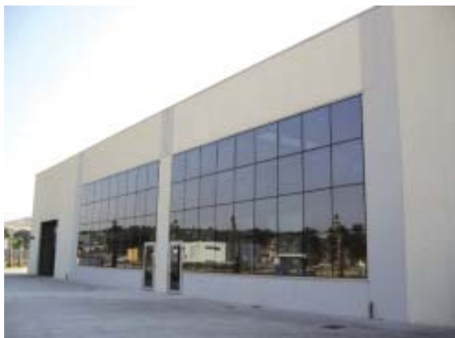
Capannone della DIATECH
